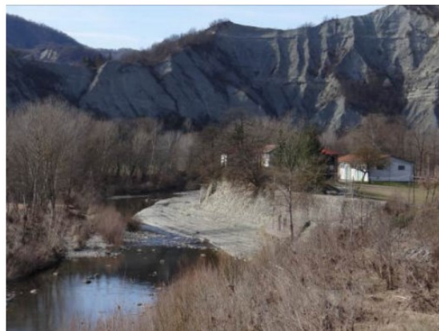
Difese in sponda destra all'inizio del tratto.
